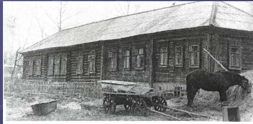
В подвальном помещении амбулатории ЦРБ находилась баклаборатория
